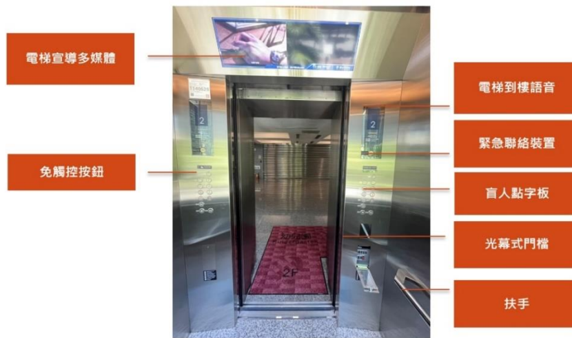
圖 7：23、25 號電梯新增內側硬體設施
