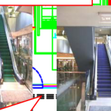
一樓東側 電扶梯
