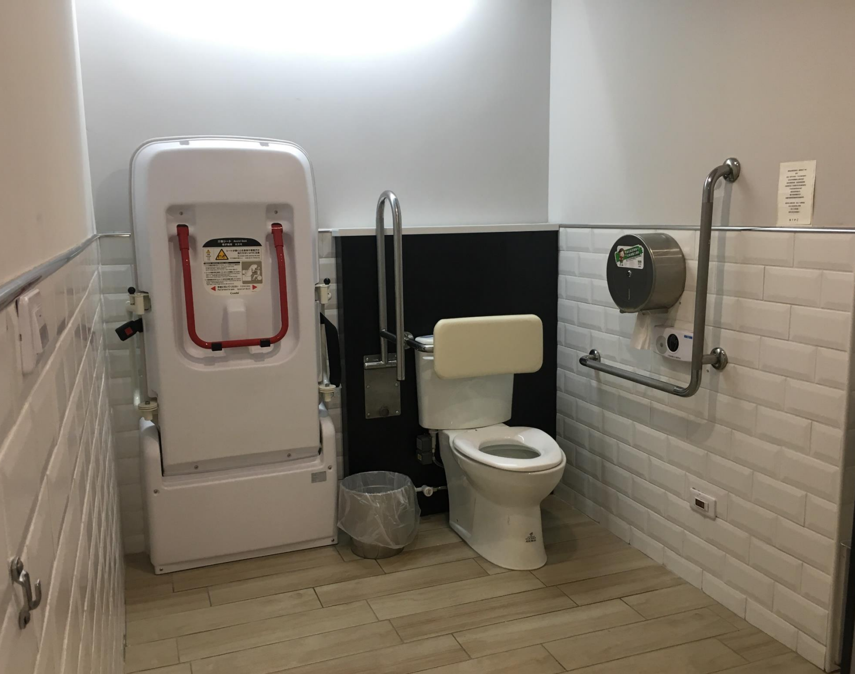
市民廣場1樓東側性別友善廁所無障礙空間
